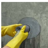
Introduire un tube de récupération et le sceller au Sika®-4a.
