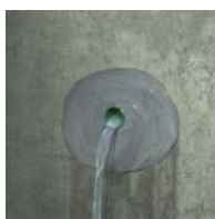
Parfaire l'imperméabilisation et ôter le drain.
