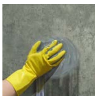
Boucher avec une carotte de Sika®-4a ciment puis recouvrir avec un enduit à la Super Sikalite®.
